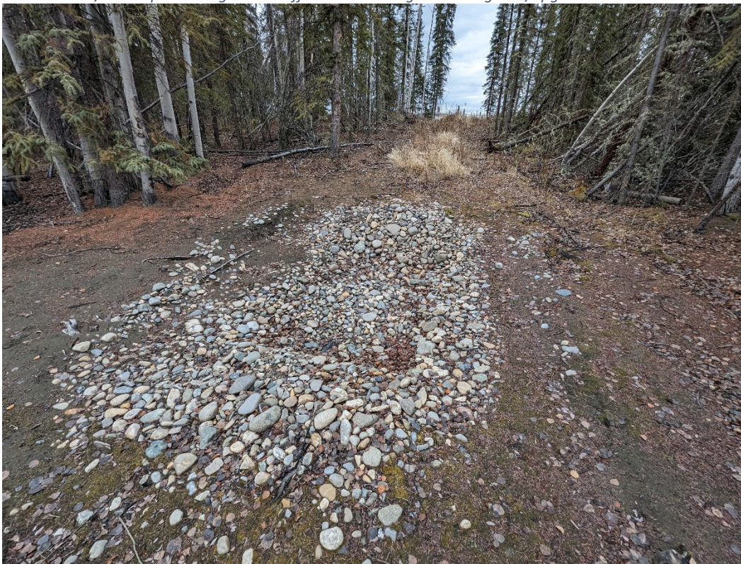
Photo 10. Effluent discharge pad
